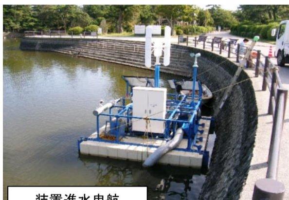
装置進水曳航
