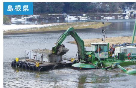
島根県 調整池堆積土砂取除工事 ダム湖に堆積した土砂の浚渫を行いました。
