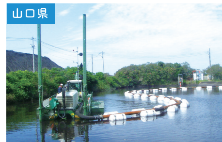
山口県 調整池浚え工事 堆積物浚渫作業を行いました。
