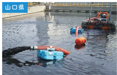
山口県 沈殿池ポンプ浚渫工事 沈殿池の堆積物を浚渫し、陸上バックホウが届く場所へ送りました。
