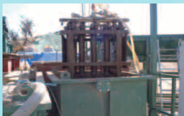
脱水機引き上げ
